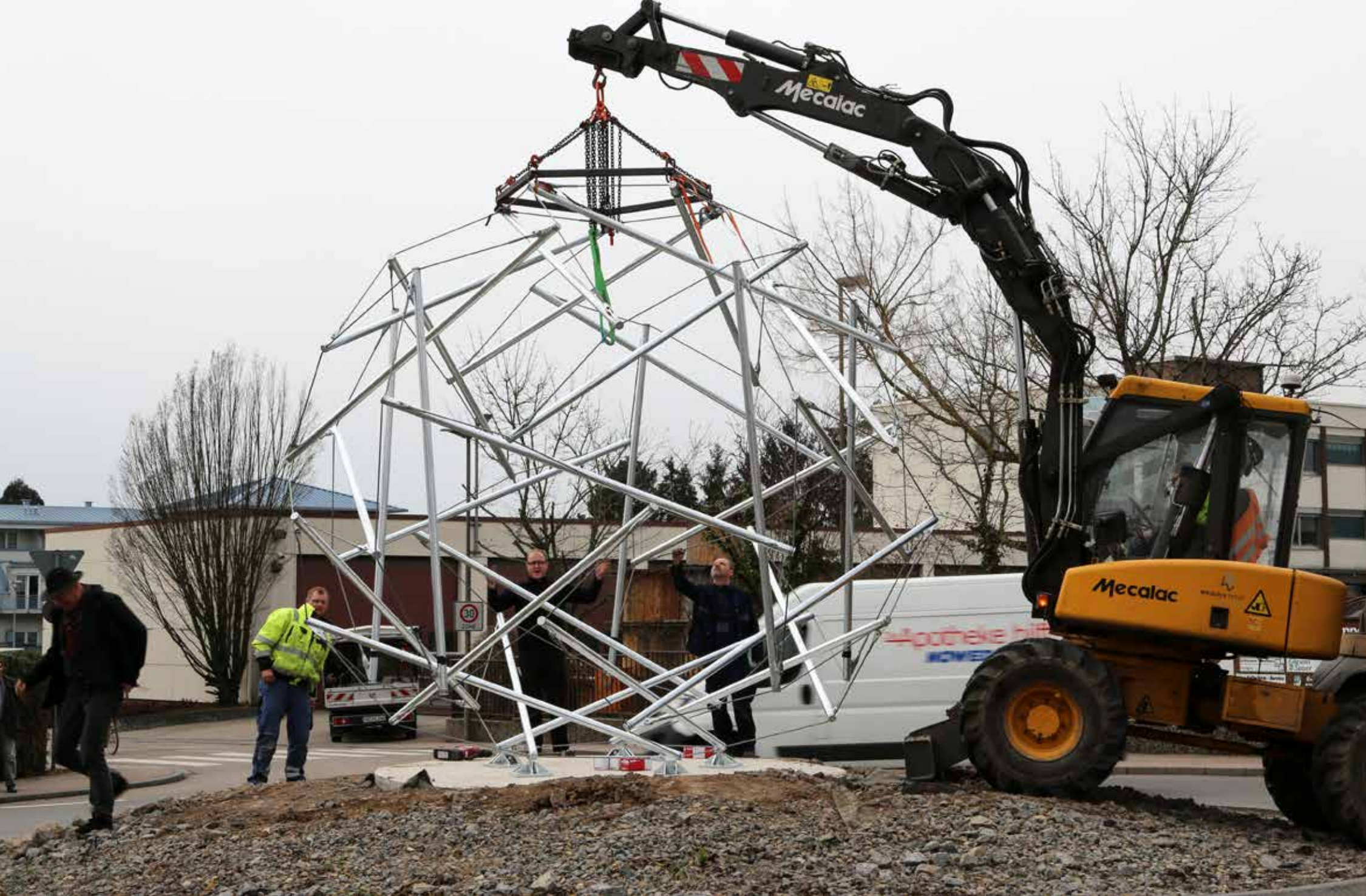
Sphären Montage mit Kran in der Stadt
